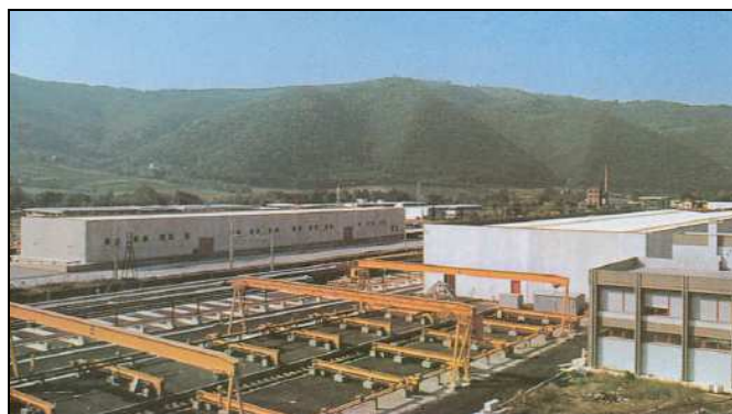
Figura 46. Impianto rigenerazione rotaie
