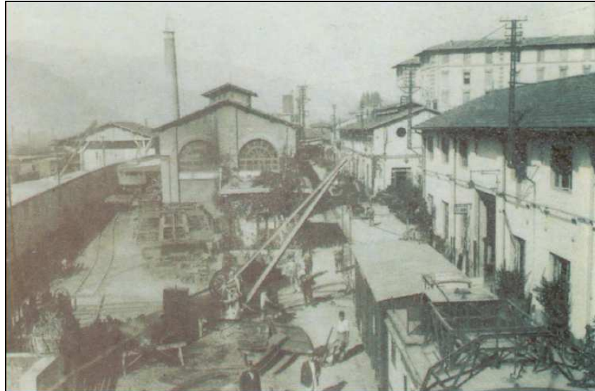
Figura 45. Le Officine ferroviarie di Pontassieve
