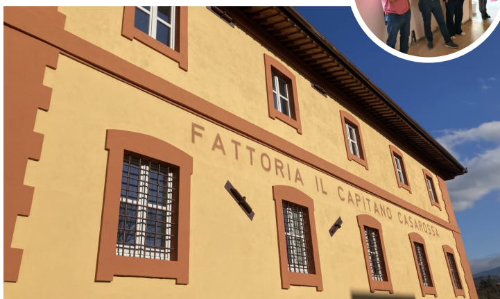
L'edificio "Casa Rossa" all'ingresso di Pontassieve
