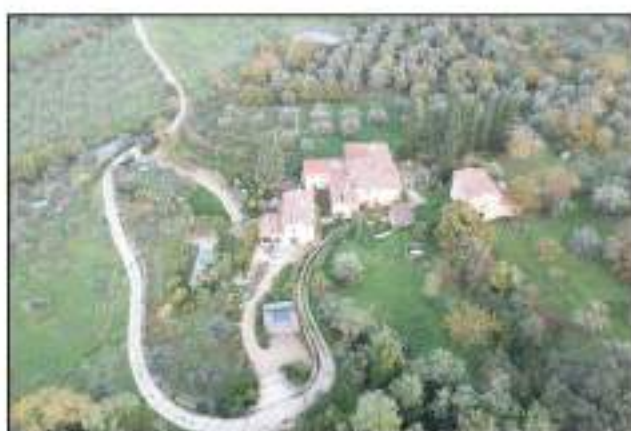
FD3 - Veduta Sud-Ovest
