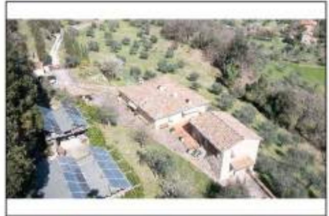
FD2 - Veduta Sud-Ovest
