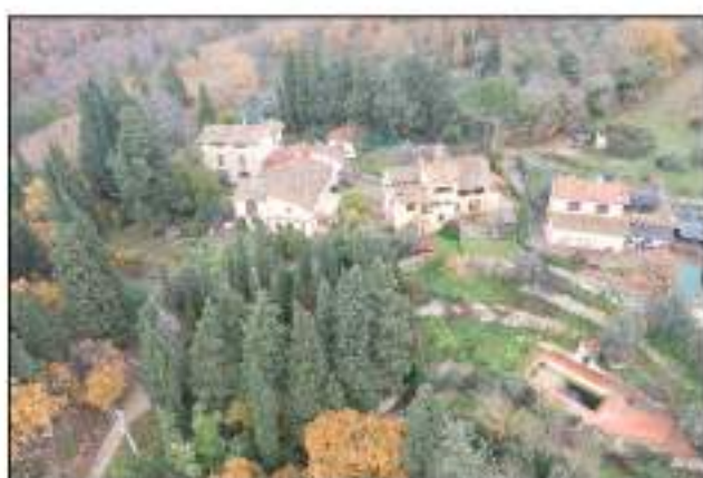
FD3 - Veduta Sud-Ovest
