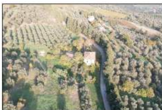
FD3 - Veduta Sud-Ovest
