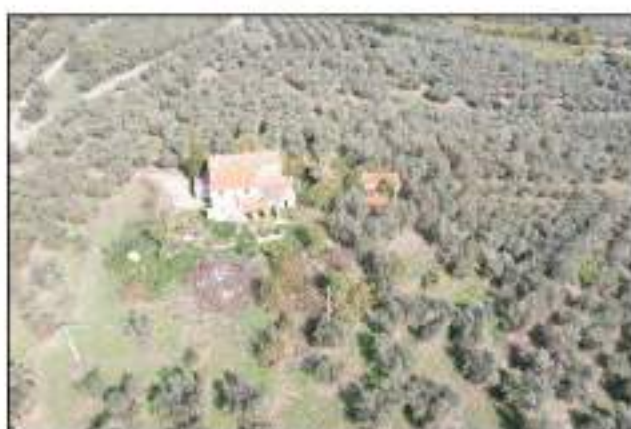
FD3 - Veduta Sud-Ovest
