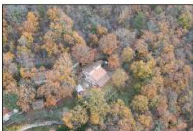
FD3 - Veduta Sud-Ovest
