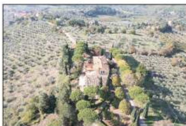
FD4 - Veduta Nord-Est
