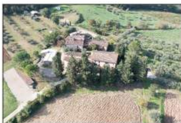
FD4 - Veduta Nord-Est
