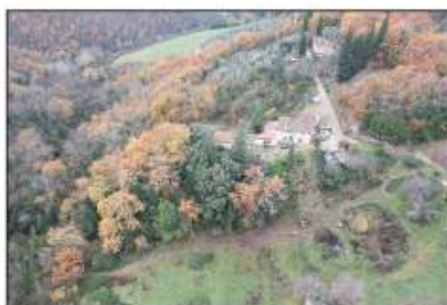
FD4 - Veduta Nord-Est
