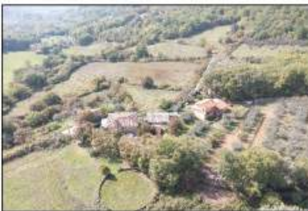
FD3 - Veduta Nord-Est
