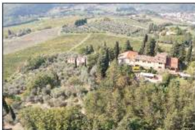
FD1 - Veduta Nord-Est
