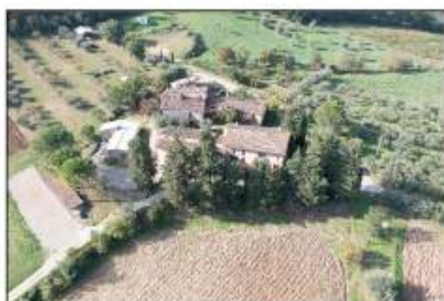
FD4 - Veduta Nord-Est
