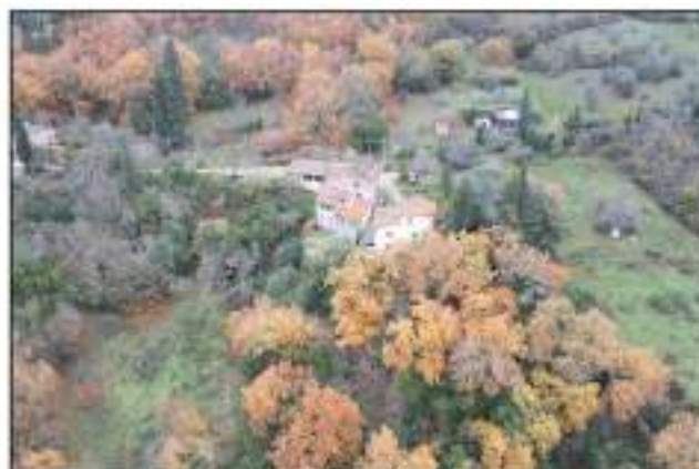
FD2 - Veduta Sud-Est
