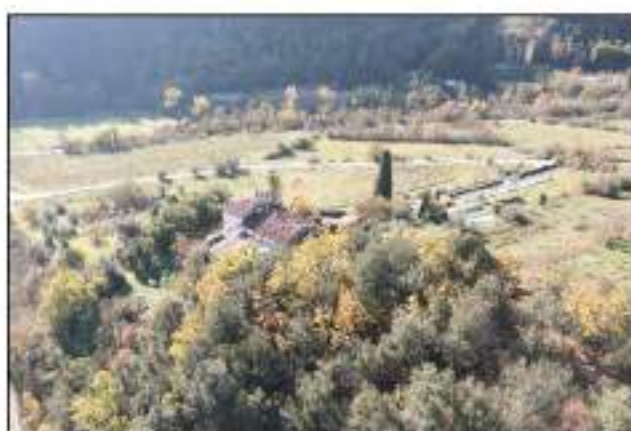
FD3 - Veduta Nord-Est
