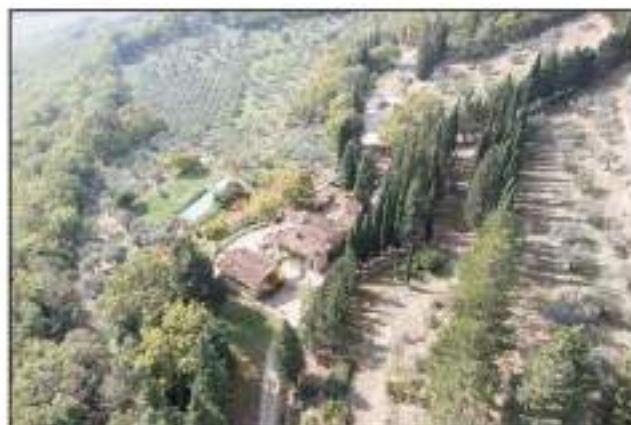
FD2 - Veduta Nord-Est
