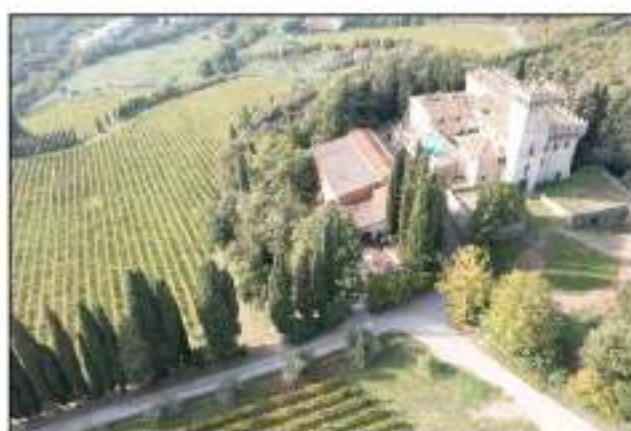
FD4 - Veduta Nord-Est
