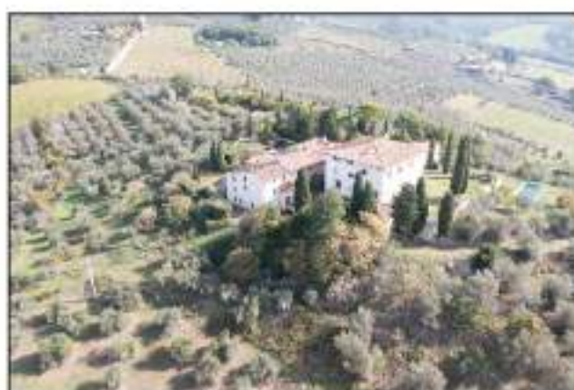
FD4 - Veduta Sud-Ovest
