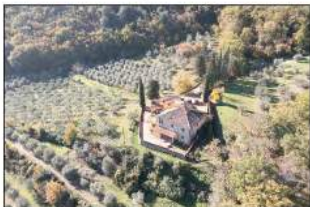
FD1 - Veduta Nord-Est
