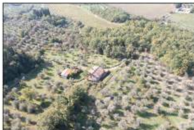
FD2 - Veduta Nord-Est
