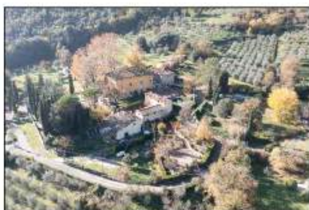
FD3 - Veduta Nord-Est
