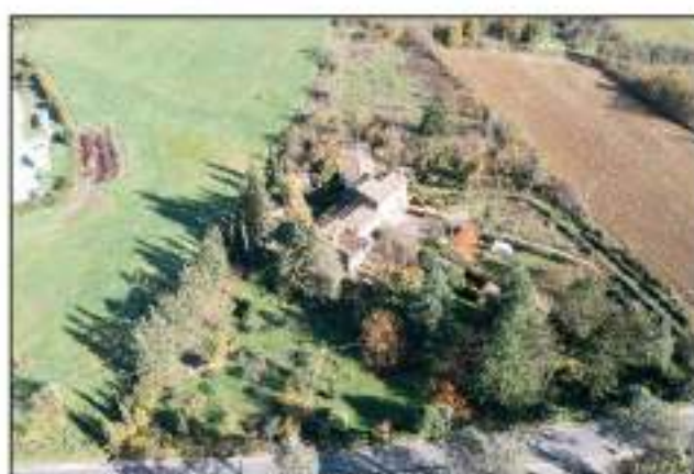
FD4 - Veduta Sud-Ovest
