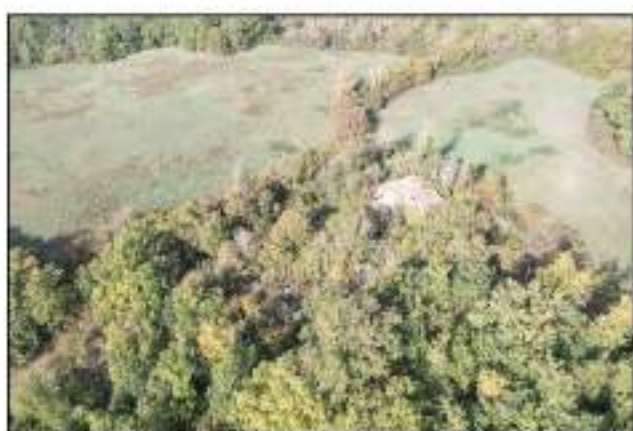
FD3 - Veduta Sud-Est
