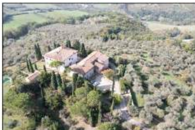
FD1 - Veduta Nord-Est
