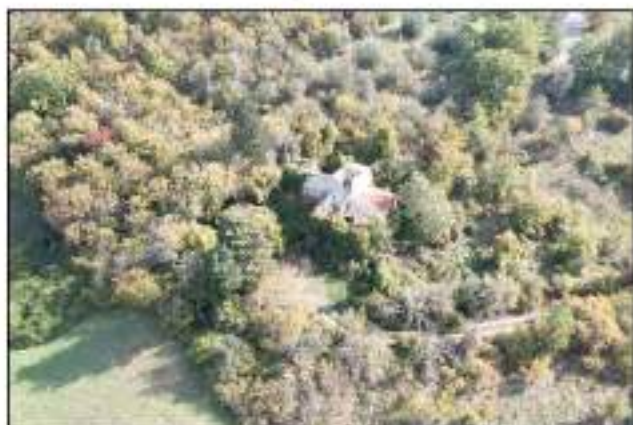
FD1 - Veduta Sud-Ovest
