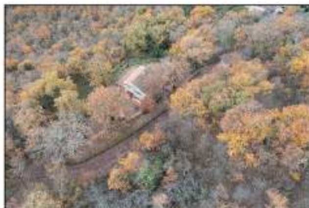
FD2 - Veduta Nord-Est
