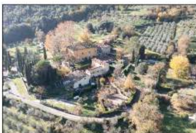
FD3 - Veduta Nord-Est
