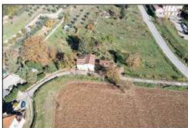
FD3 - Veduta Sud-Ovest
