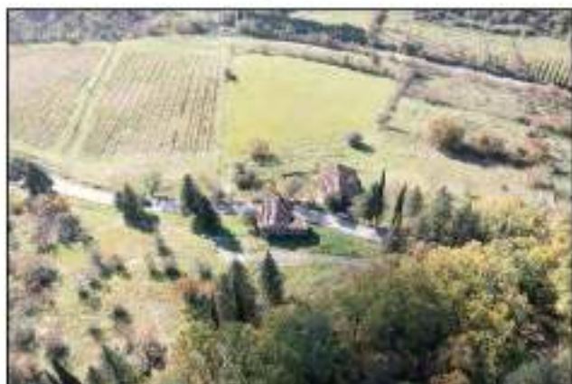
FD1 - Veduta Nord-Est
