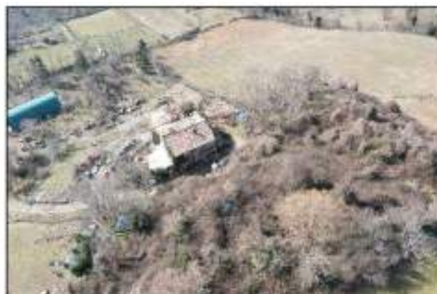
FD2 - Veduta Nord-Est
