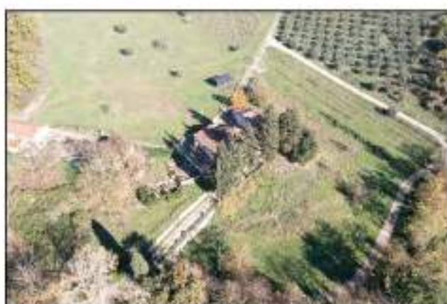
FD3 - Veduta Sud-Ovest
