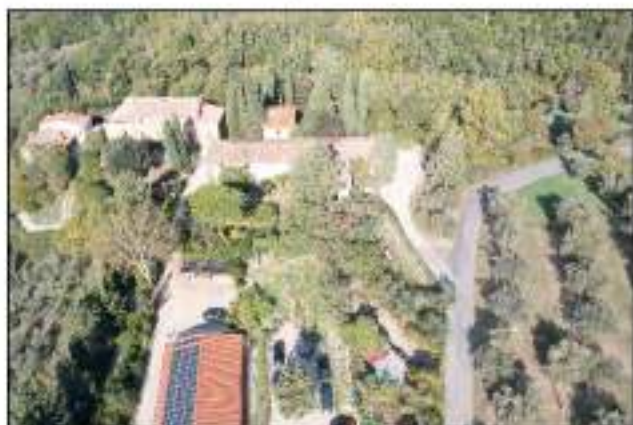
FD1 - Veduta Sud-Est
