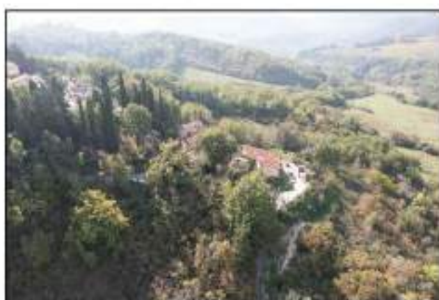
FD3 - Veduta Nord-Est
