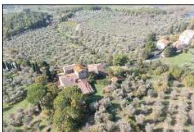
FD3 - Veduta Nord-Est
