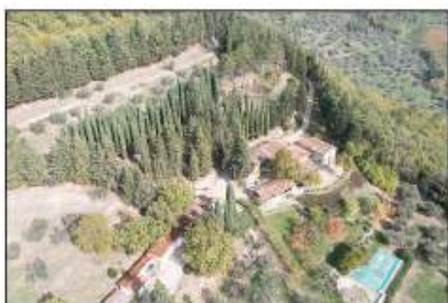
FD3 - Veduta Sud-Ovest
