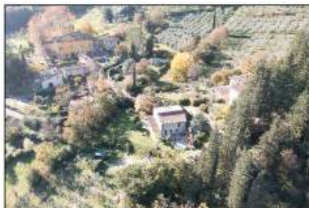
FD2 - Veduta Nord-Est
