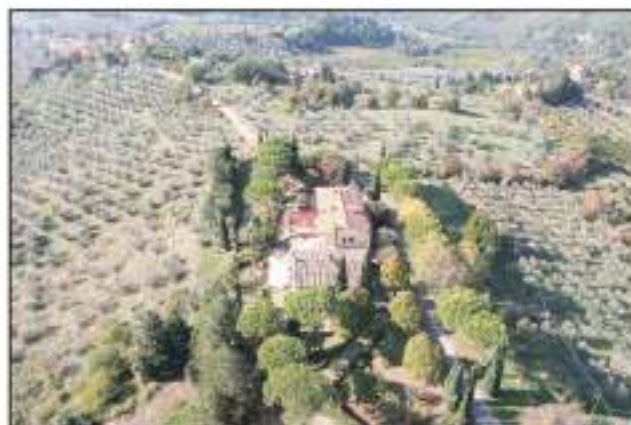
FD2 - Veduta Nord-Est
