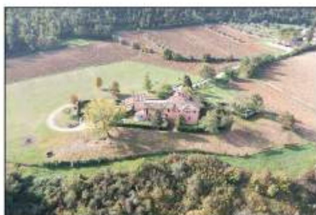
FD4 - Veduta Nord-Est
