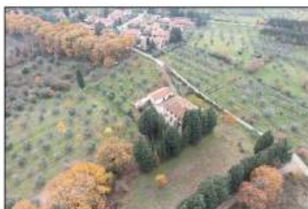
FD4 - Veduta Nord-Est
