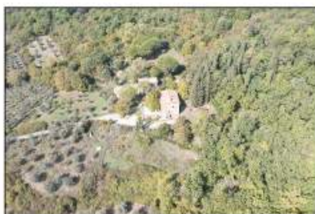
FD4 - Veduta Sud-Est
