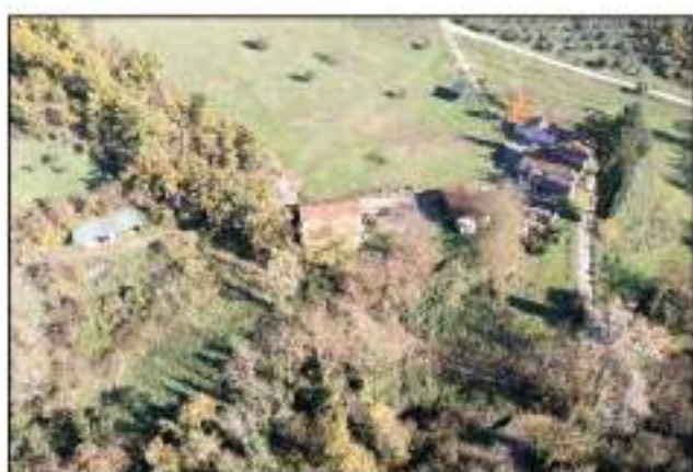
FD3 - Veduta Sud-Ovest
